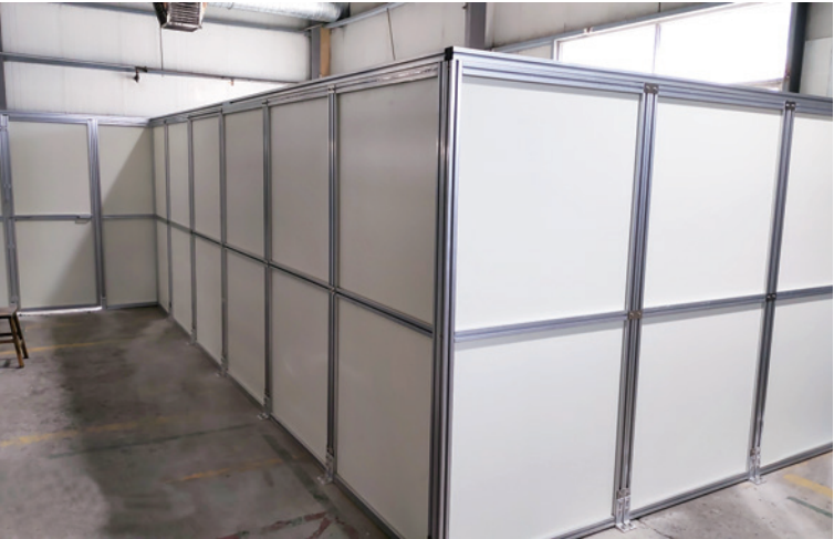
◎ 新建车间不透明安全隔断
