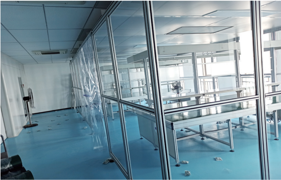
◎ 现场 PC 透明安全房施工
