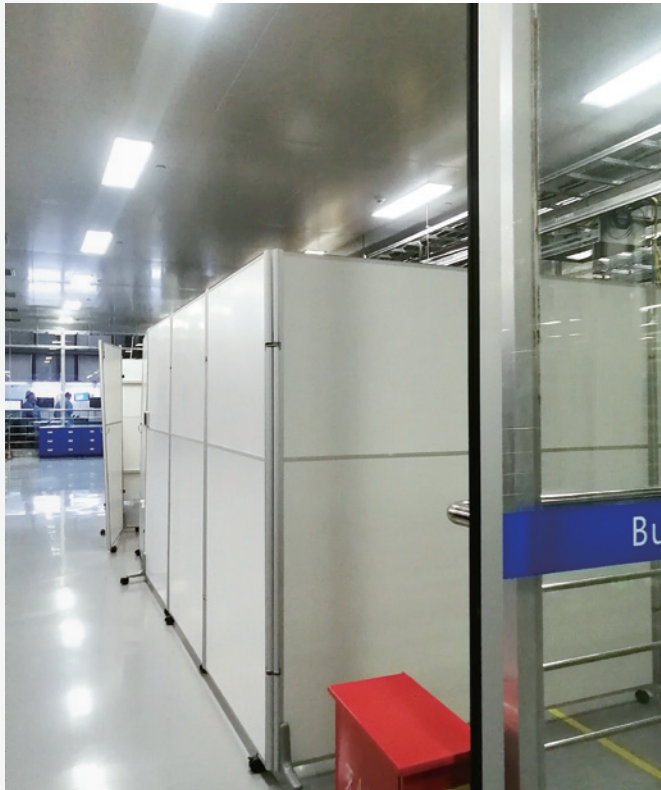
◎ 精密仪器设备室隔断
