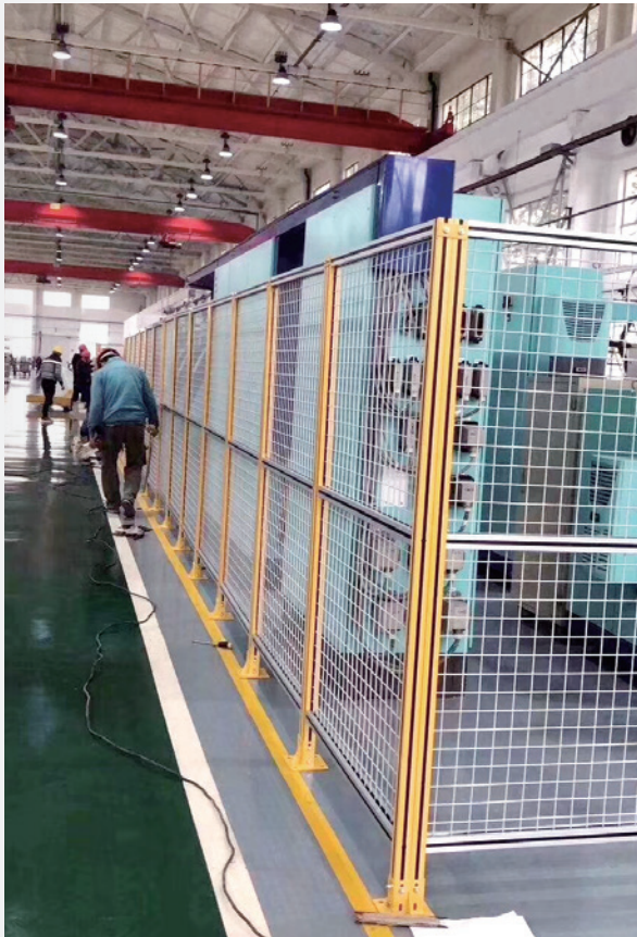
◎ 现场铝型材围栏施工
